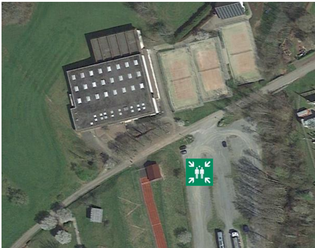
Abbildung 2 | Luftbild des Gebäudes mit Darstellung der Sammelstelle [Quelle: Google Earth™-Kartenservice]
