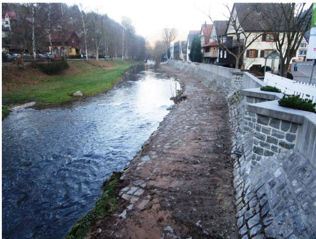
Erhöhung von Ufermauern an der Kinzig
