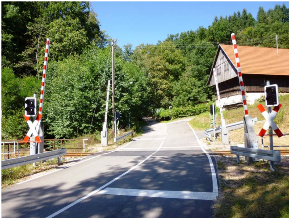
Bahnübergang Vor Kuhbach
